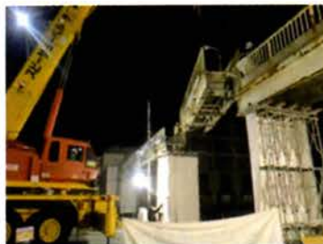
平成28年3月、歩道橋を6つに切断してクレーンで取り外し撤去されました。
