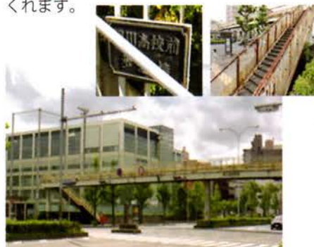
平成28年3月、歩道橋を6つに切断してクレーンで取り外し撤去されました。
